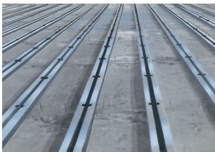
レール型定盤の施工例
